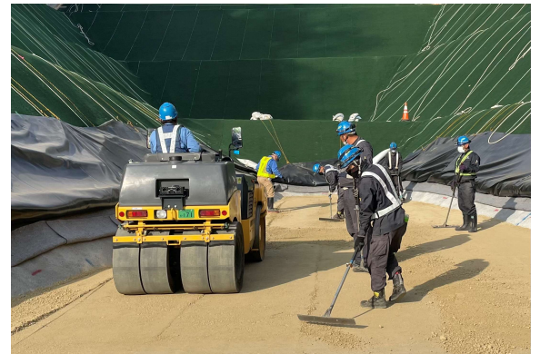
NB工法施工状況
