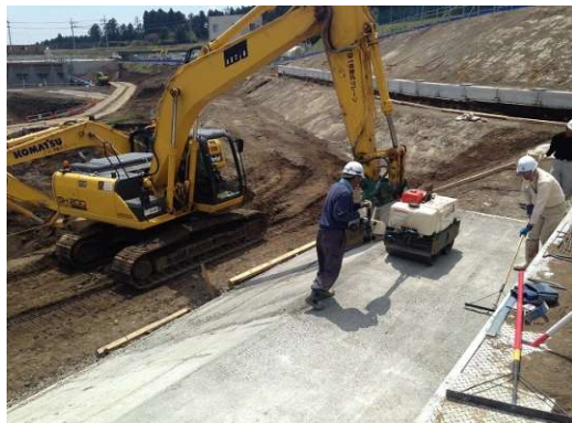
静岡県裾野市平成26年度管理型最終処分場 ベントナイト層敷設工事
