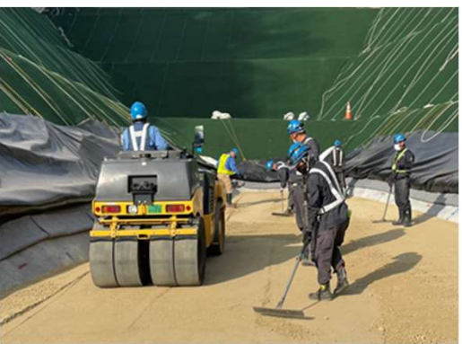
神奈川県令和3年度かながわ環境整備センター ベントナイト層敷設工事
